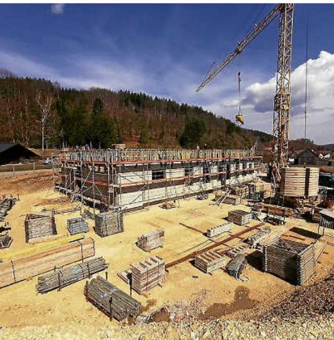
Der Bau des neuen Wasserwerks für den Zweckverband Wasserversorgung Unteres Aitrachtal, in dem zukünftig das Trinkwasser aller Brunnen gemeinsam aufbereitet wird, schreitet voran. Mit den Betonierarbeiten für die Decke und den Estricharbeiten schließt die Firma Hermann die Rohbauarbeiten ab.
