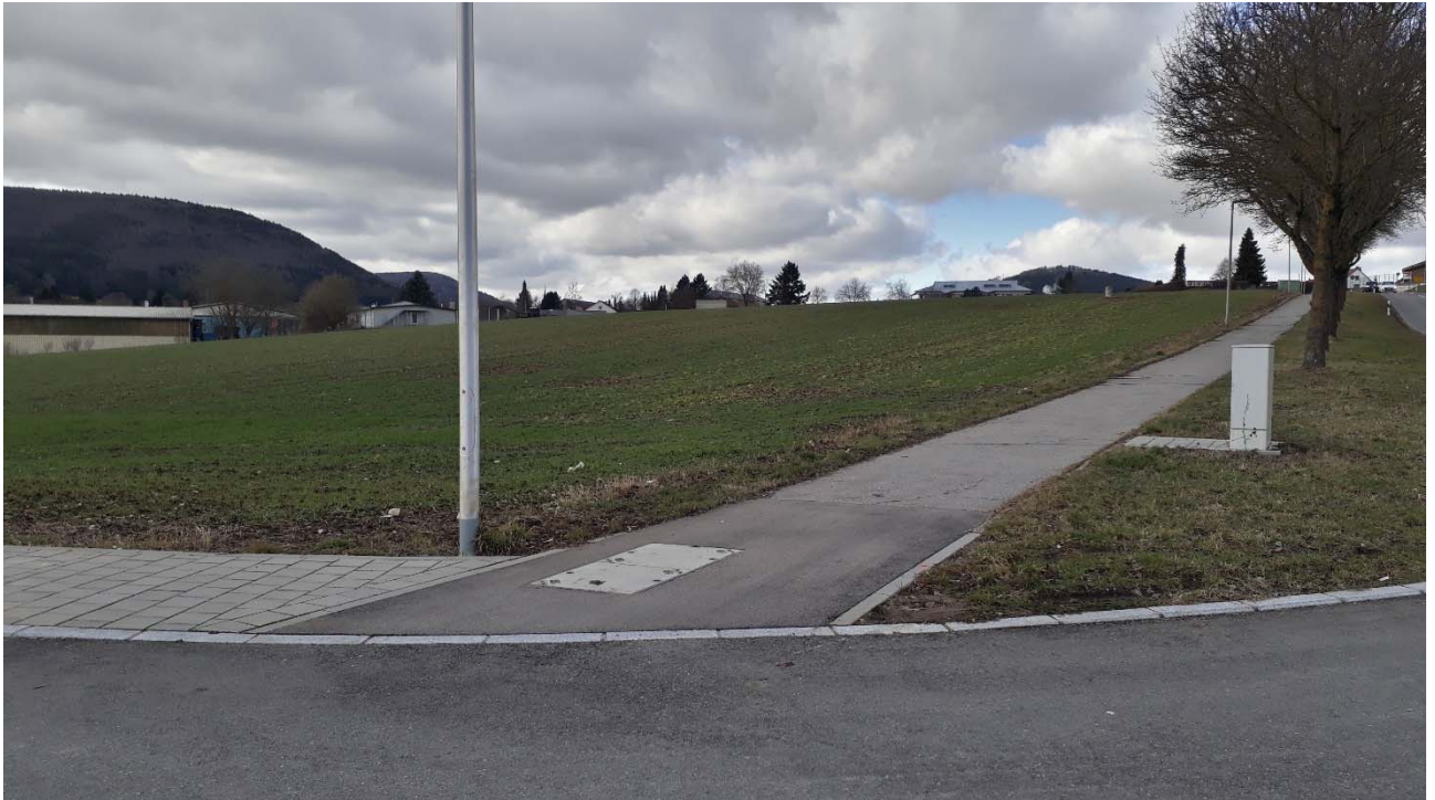
Nordöstlichster Punkt des Geltungsbereichs mit Zufahrtsstraße (links) zur Fa. Pajunk (vgl. Anhang 2)
